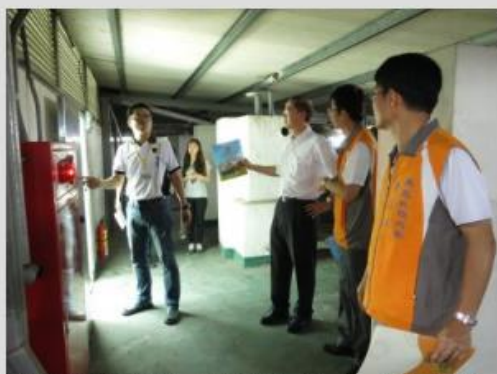
嘉義縣消防局火災預防科長陳南合（左）檢查學生租屋處消防設備。（吳鳳科技大學提供）
