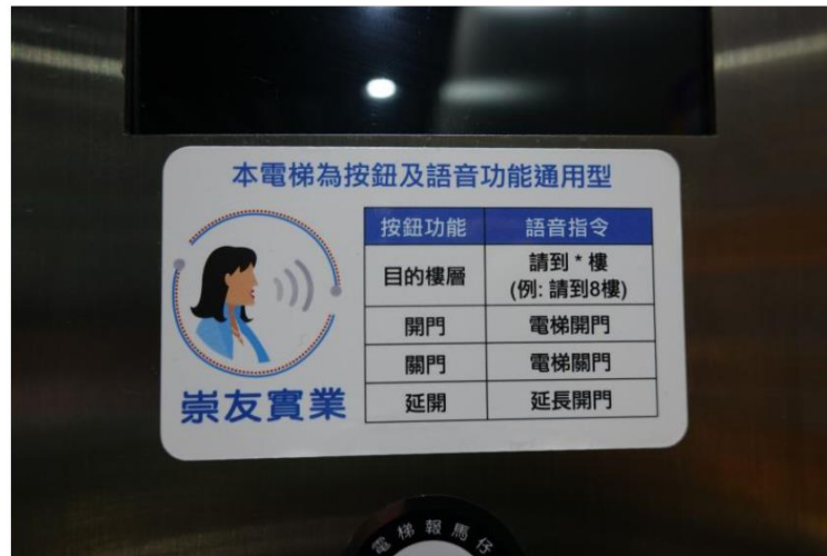
▲電梯安裝智慧聲控，配合語音功能即可達到想去的樓層。(圖/吳鳳科大提供)
